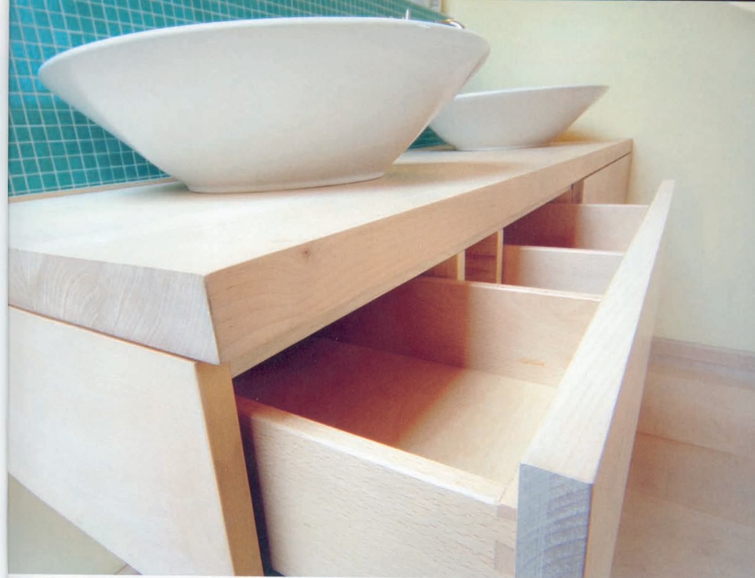
Die Badmöbel sind aus massivem, weiß geöltem Ahorn gefertigt. Gezinkte Schubladen mit Aussparungen für die Siphons nutzen den Platz unter den Waschbecken
